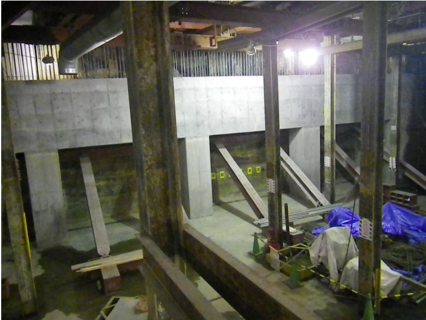
③地下広場(半蔵門線側) 側壁施工完了
