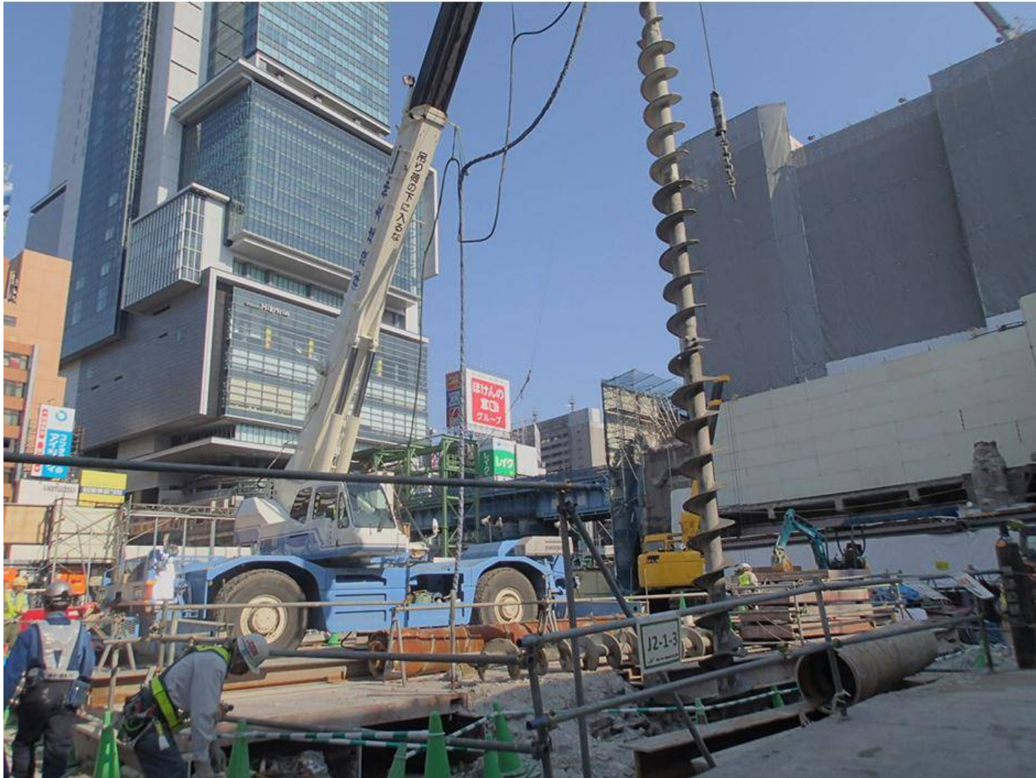
⑨渋谷川仮護岸杭打設状況
