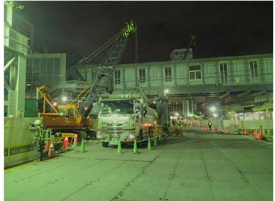
⑤ワイヤークラムによる残土積込・搬出状況
