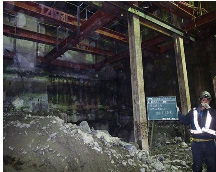
⑦既設14番出入口解体状況
