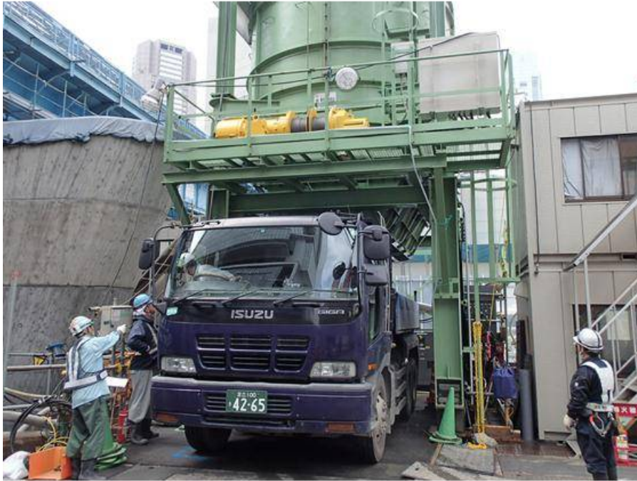
④土砂ホッパーによる残土積込・搬出状況
