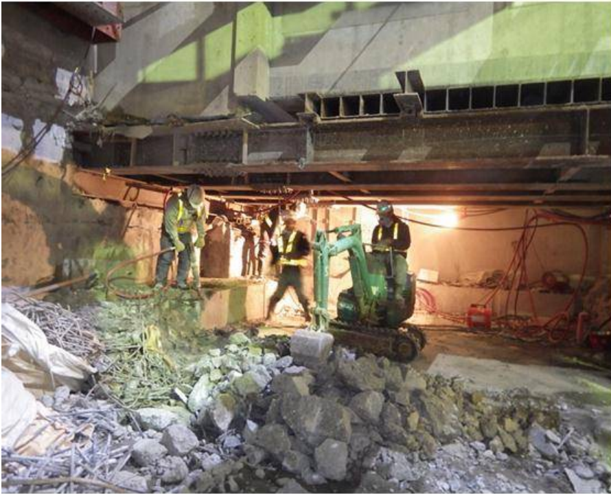
⑥既設換気塔解体状況
