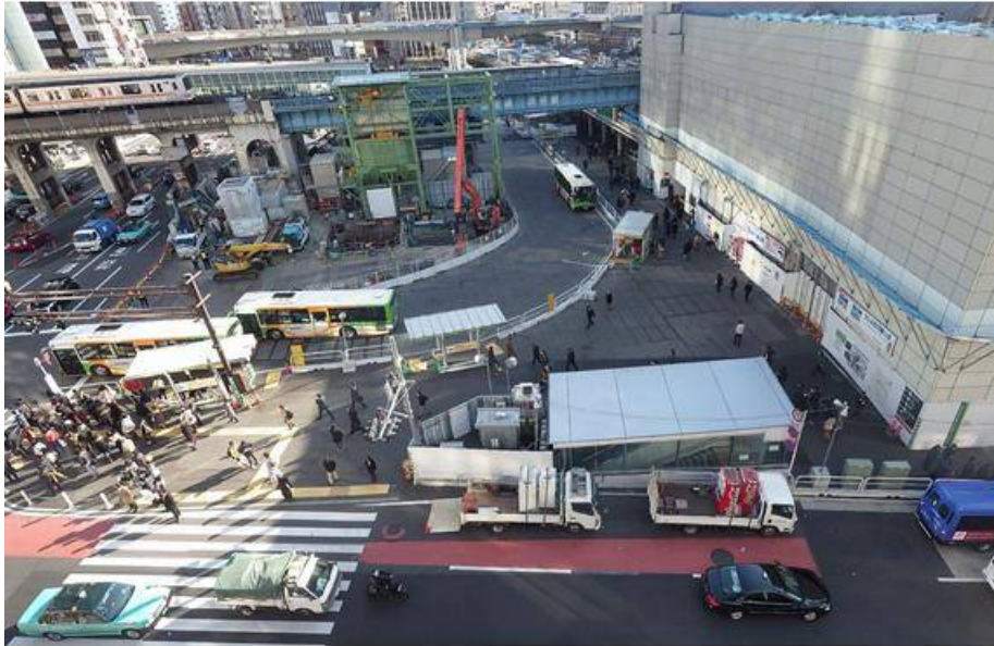
①東口バスロータリー全景(北側 H26.1下旬)
